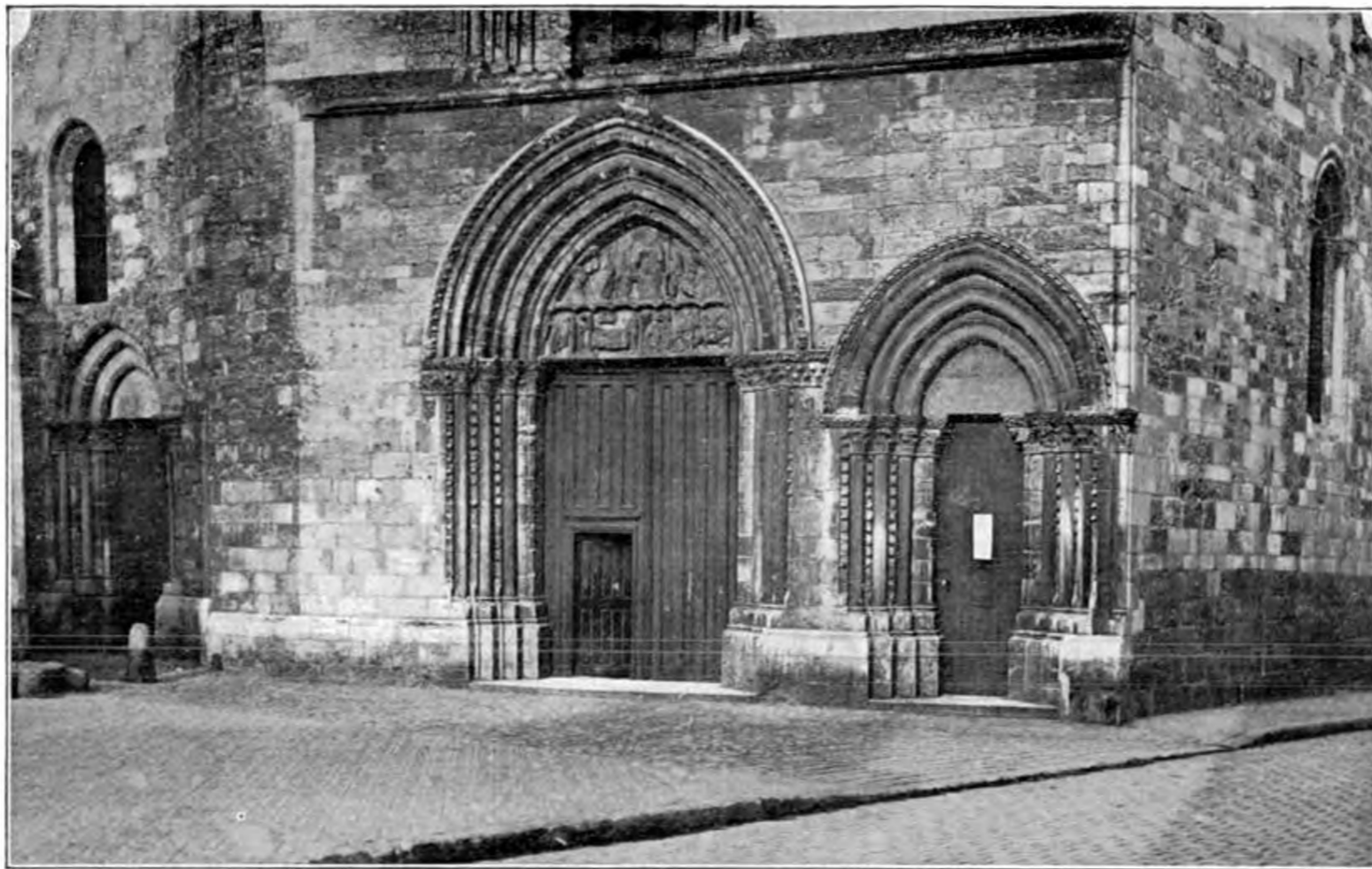
EGLISE NOTRE-DAME, A ETAMPES Façade occidentale et angle de la façade méridionale.
