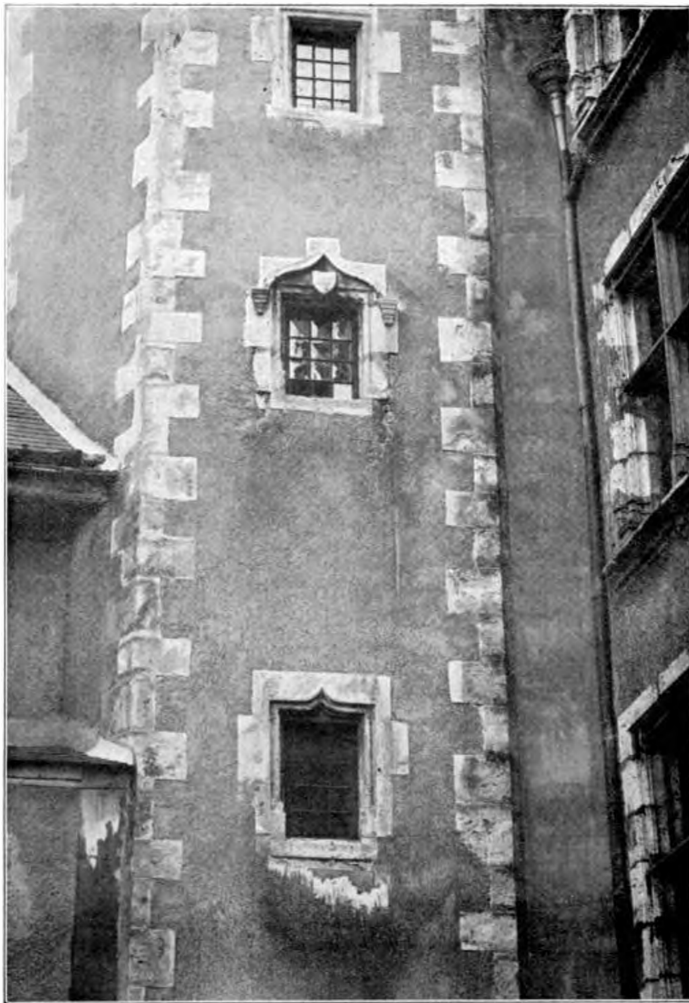
Pl. IV. — Grand-Hôtel-Saint-Yon. Tourelle d'escalier
