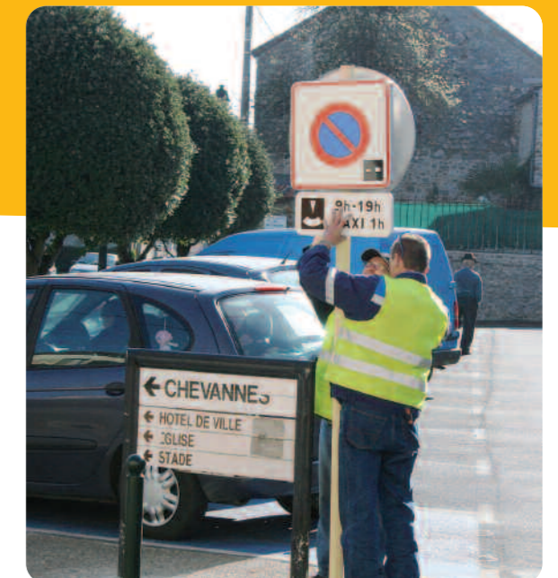
La pose des panneaux par les employés communaux.
