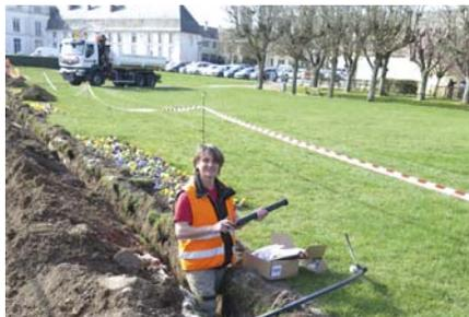
Le service Espaces verts a procédé à l'installation de l'arrosage automatique sur le parc François-Mitterrand courant mars. Pour cela, ils ont creusé deux tranchées de 100 mètres chacune permettant l'installation des cinq tuyaux d'arrosage par tranchée. Le but de l'opération : baisser la consommation en eau, avec un arrosage plus adapté que l'arrosage manuel.
