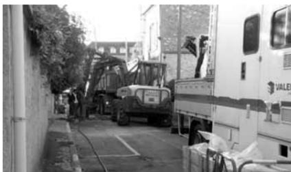
**Rues des Aveugles et Rose-Chéri.** La réfection du réseau d'assainissement (eaux usées et eaux pluviales) a démarré. Les canalisations ont été inspectées à l'aide d'une caméra motorisée...
