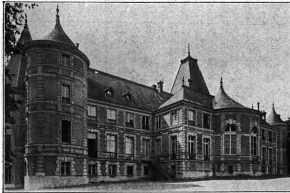
Château de Montgermont (Seine-et-Marne).
