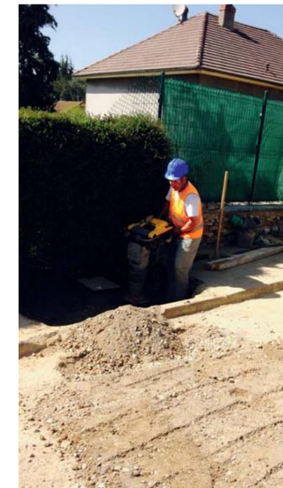
L'opération a consisté à prolonger le réseau sur ce tronçon de voie, via le collecteur, et à raccorder 8 branchements de riverains à cette extension du collecteur (les autres riverains ont préféré ne pas être raccordés à ce réseau et continuer à utiliser une fosse septique).
