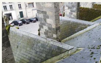
L'étude, commanditée par la Ville, et réalisée par le cabinet LARPIN concerne l'élévation sud-est du clocher, les couvertures et élévations des deux premières chapelles nord-est. Des travaux nécessités par le mauvais état des couvertures et des arcs-boutants pouvant à terme mettre en cause la stabilité de ces ouvrages et entraînant des fuites d'eau et un ruissellement de l'eau sur les parois domageable à l'édifice.
