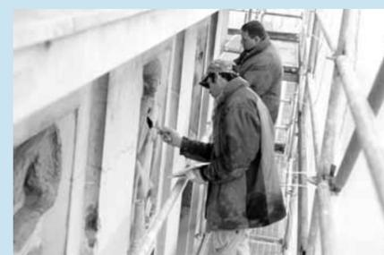
faire office de "lifting". Elle est ensuite retirée via un jet d'eau. « *Cette technique est plus douce qu'un nettoyeur haute pression à l'eau ou au sable* », ajoute-t-il. Il est maintenant temps de procéder à la restauration des sols, des huisseries extérieures, de la toiture et de créer l'accès pour les personnes à mobilité réduite. L'opération qui est programmée pour une durée de 10 mois ne nuira pas pour autant au bon déroulement des rendez-vous culturels.
