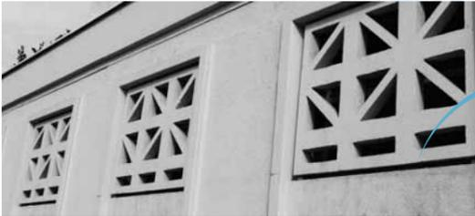
Le moucharabieh est un dispositif de ventilation naturelle qui était utilisé dans l'architecture traditionnelle des pays du Moyen-Orient. Celui-ci a été réalisé par Pierre-Edouard Lambert, collaborateur de l'architecte qui a travaillé à la reconstruction du Havre.
