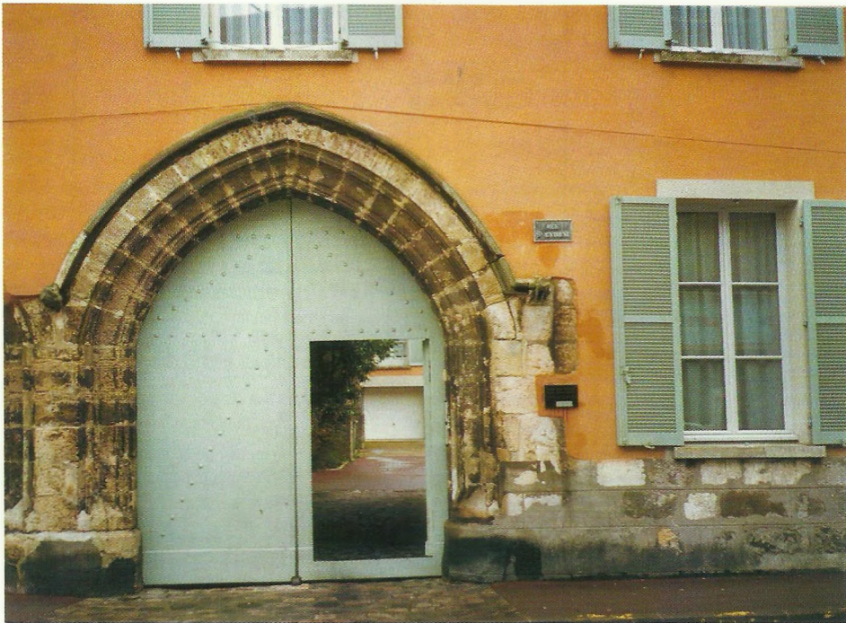
Portail du palais du Séjour état avril 1999 (ancienne gendarmerie).
